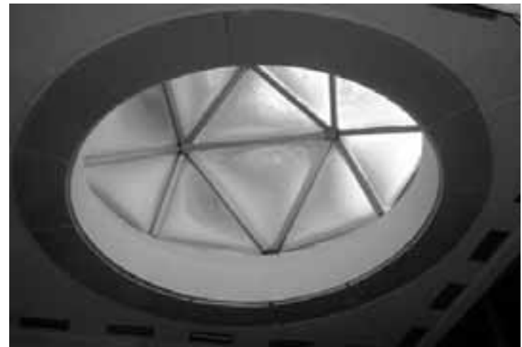
Kupola plexiglas - mbrojtës efikas nga rrezet ultraviolete
